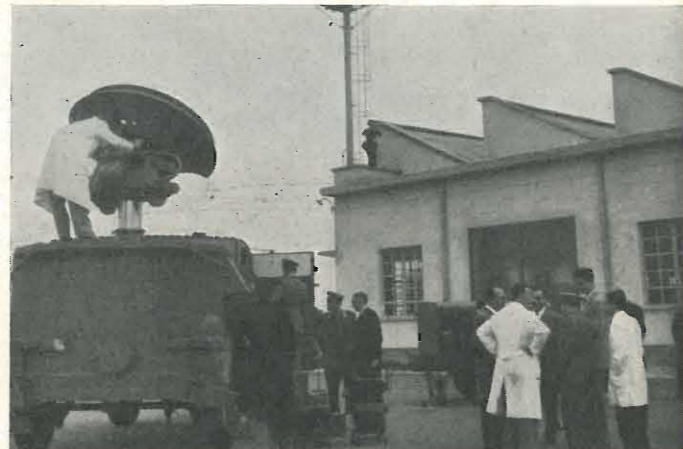
Un gruppo di tecnici della F.I.A.R. attorno al radar AA N° 3 Mk 7 poco prima della dimostrazione pratica di inseguimento di un bersaglio mobile. Fino alla sua uscita dalla zona d'ombra (circa 1 km) il bersaglio, costituito da un palloncino metallico, viene seguito otticamente mediante cannocchiale fissato sulla parte posteriore del paraboloide.
